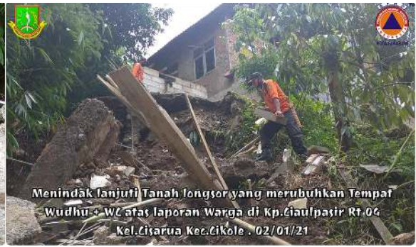
Menindak lanjuti Tanah longsor yang merubuhkan Tempat Wudhu + WC atas laporan Warga di Kp.Ciaulpasir Rt 04 Kel.Cisarua Kec.Cikole . 02/01/21
